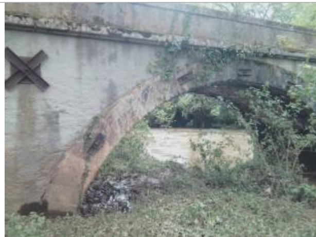
Vue du site - auteur : Artelia
