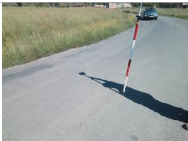
Vue du repère - auteur : Artelia
