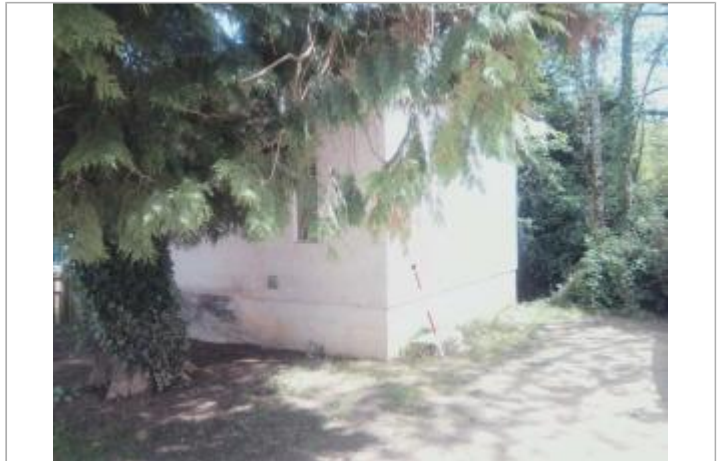
Vue du site - auteur : Artelia
