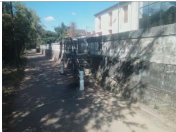
Vue du site - auteur : Artelia
