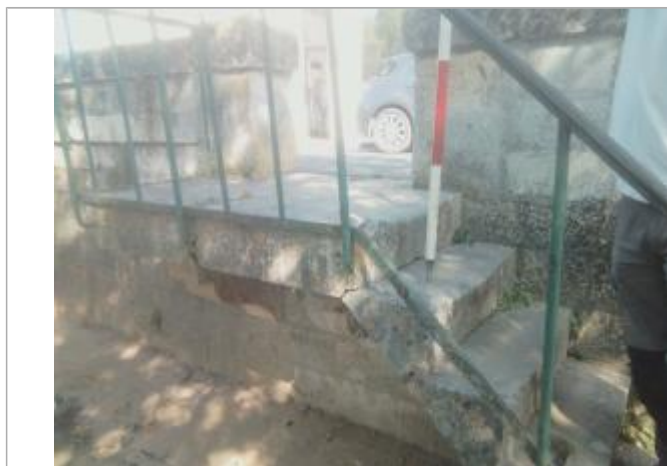
Vue du repère - auteur : Artelia
