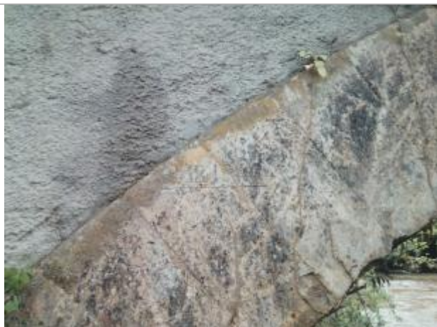
Vue du repère - auteur : Artelia
