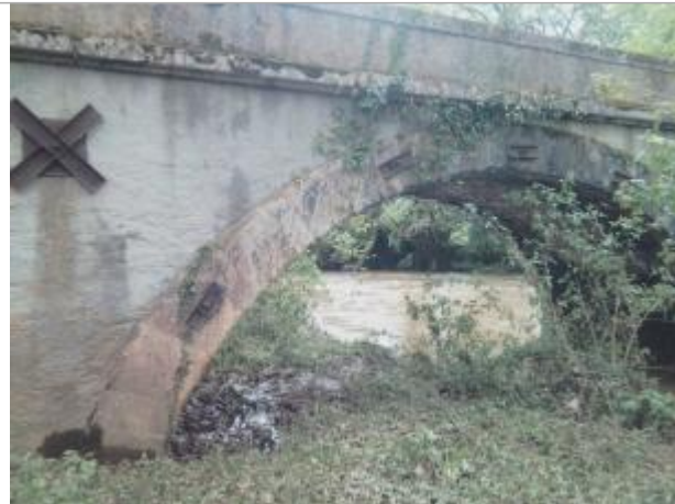
Vue du site - auteur : Artelia
