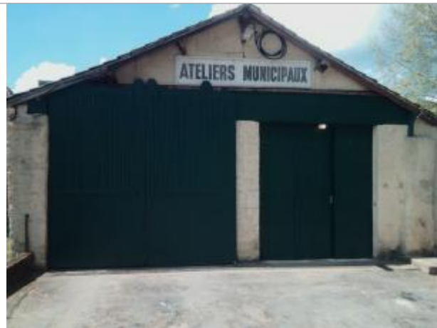
Vue du site - auteur : Artelia
