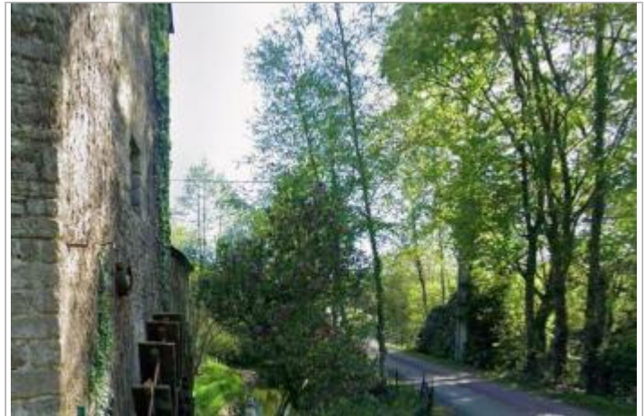
Accès au pont Moulin du Bragoux
