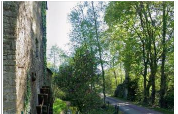
Accès au pont Moulin du Bragoux
