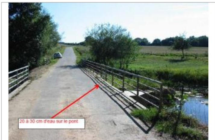
Pont Moulin du Bragoux
