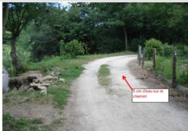
Pont chemin d'accès Moulin du Helfaut commune de Elven
