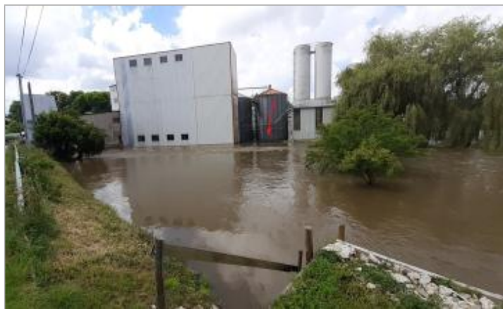
2024_Vue de la crue du 20/06/2024
