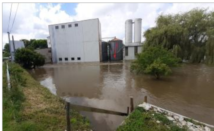
2024_Vue de la crue du 20/06/2024
