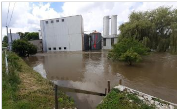
2024_Vue de la crue du 20/06/2024
