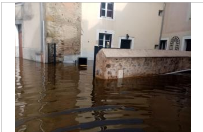
2024_Photos prise lors de la crue - 09:45
