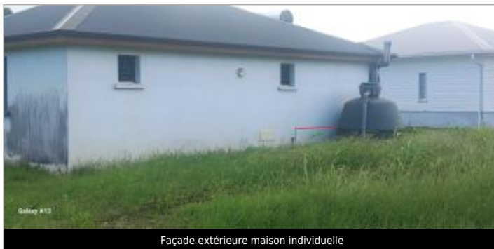
Façade extérieure maison individuelle
