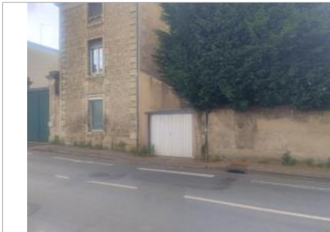
Vue sur la façade
