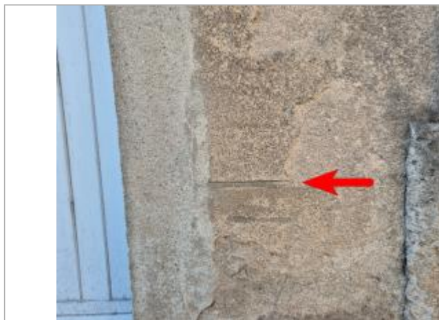
Vue sur l'encoche (supérieure)
