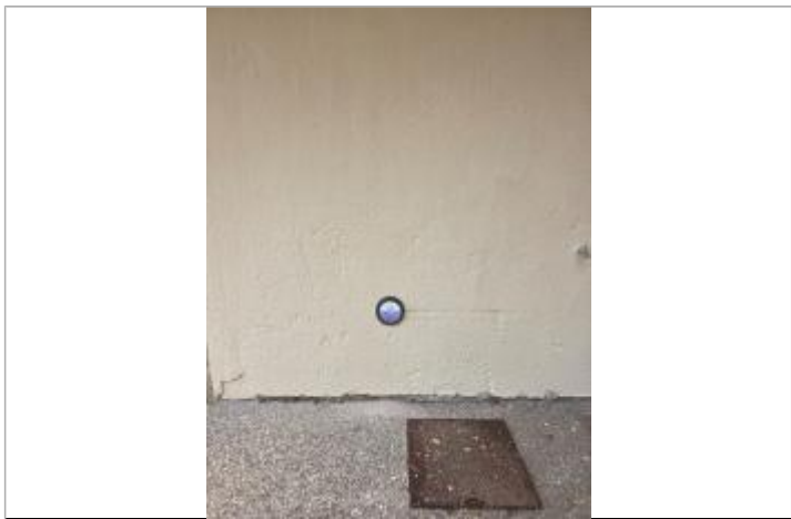
Repère POIT07-R installé sur le mur des toilettes publiques Boulevard du Pont Joubert
