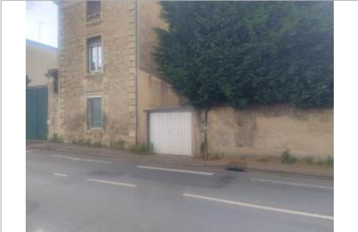
Vue sur la façade
