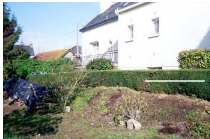
Arrière de la maison au n°7 rue du Lac à Rohan (repère inondation 2001)
