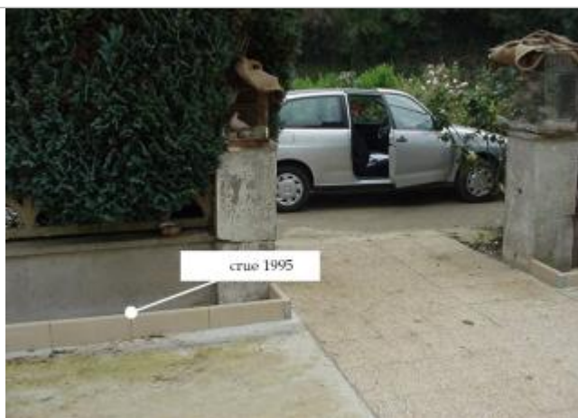
Relevé de la laisse d'inondation à l'entrée de la propriété
