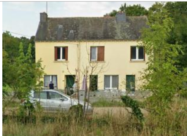
Maison au n°1 du lieu-dit "La Croix Neuve"
