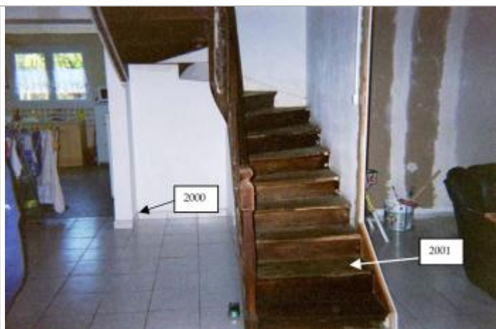
Relevé des laisses d'inondation de 2000 et 2001
