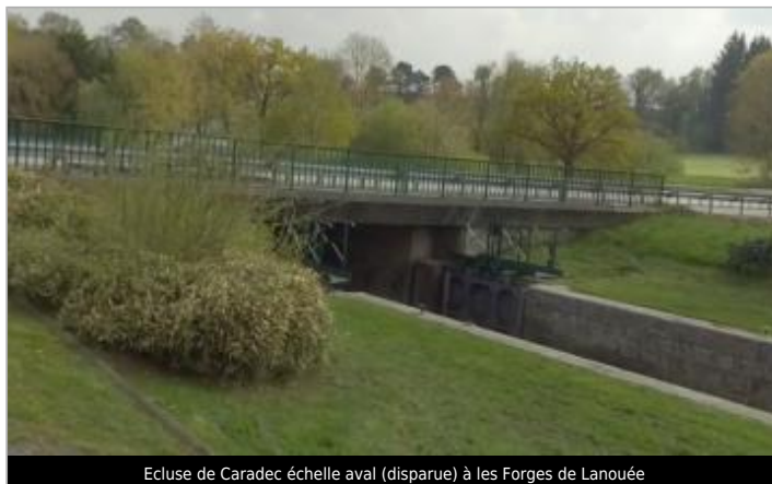
Ecluse de Caradec échelle aval (disparue) à les Forges de Lanouée
