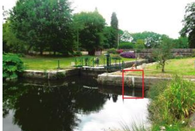
Ecluse de Cadoret amont à Pleugriffet
