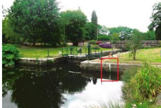
Ecluse de Cadoret amont à Pleugriffet
