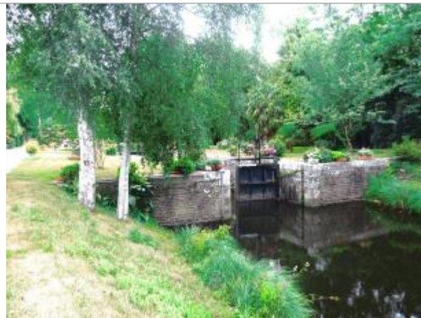
Ecluse du Lié aval à Pleugriffet
