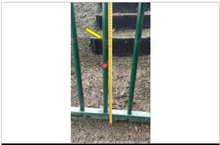
Dépôt de sédiments/végétation sur les barreaux de la porte. Mesure prise sur le barreau du milieu.
