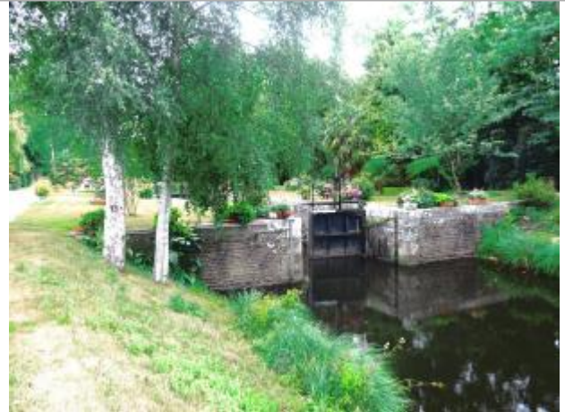
Ecluse du Lié aval à Pleugriffet
