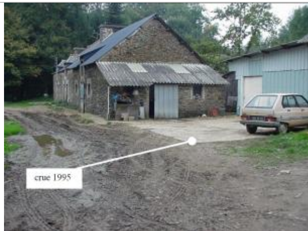
Dalle béton du moulin de l'Isle à Bréhan
