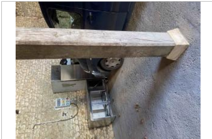
Vue sur le pilier en bois
