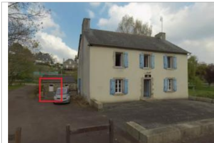
Mur de l'annexe de la maison éclusière de Rohan
