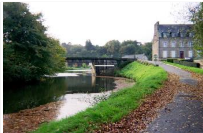
Relevé sous le pont Notre Dame en novembre 2001
