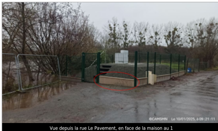
Vue depuis la rue Le Pavement, en face de la maison au 1
