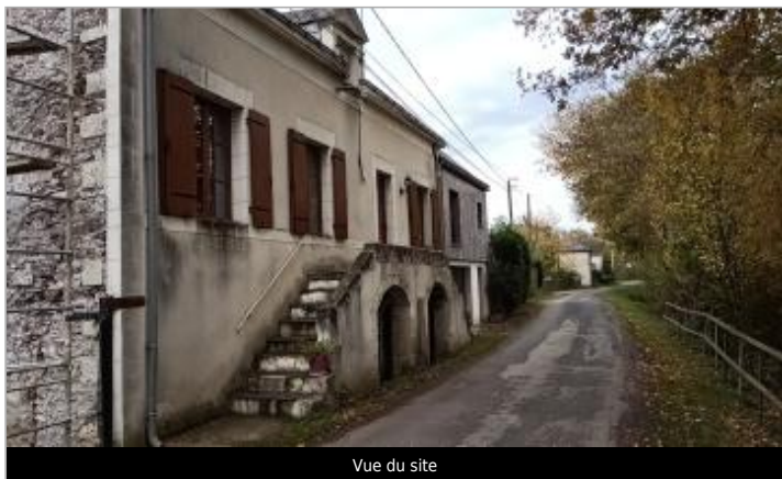
Vue du site
