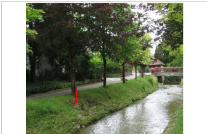
Haut de l'enrochement en rive gauche
