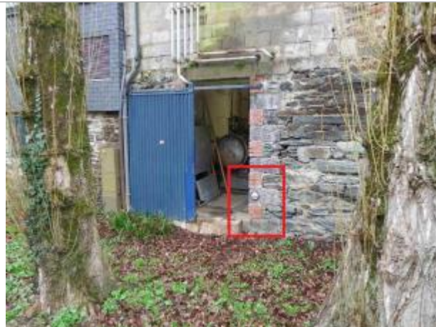
Mur d'une usine de confection, coté chemin de halage
