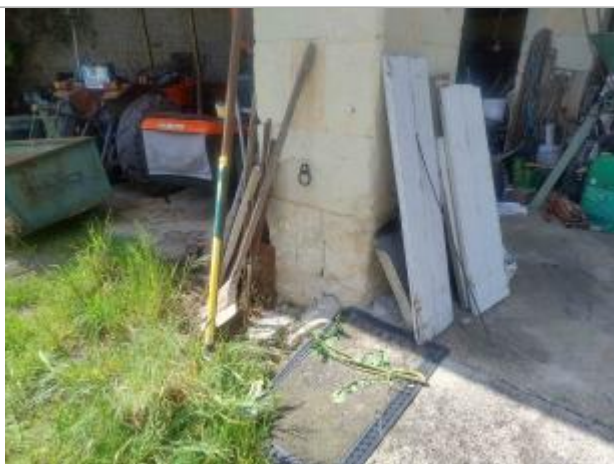
Vue sur l'anneau "marqueur visuel" de la hauteur d'eau
