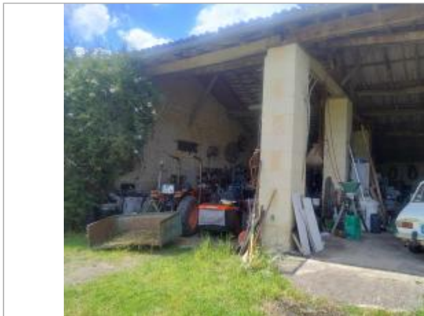
Vue sur le pilier central de la grange
