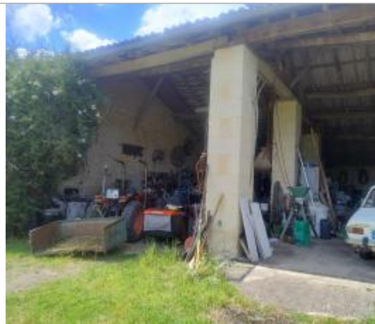
Vue sur le pilier central de la grange
