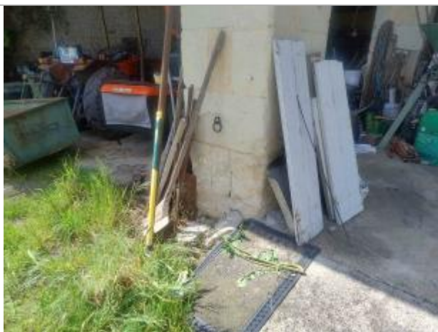
Vue sur le pilier
