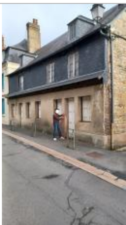
Laisse de crue à 122.5 cm/sol.
