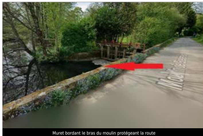
Muret bordant le bras du moulin protégeant la route
