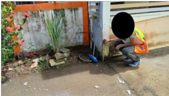
Dépôts de matières solides
