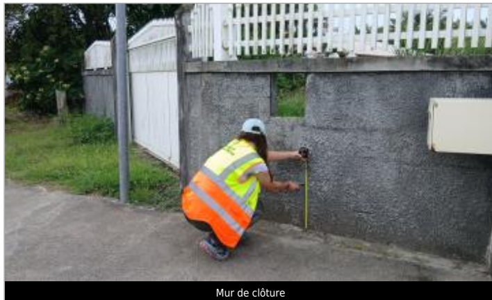
Mur de clôture
