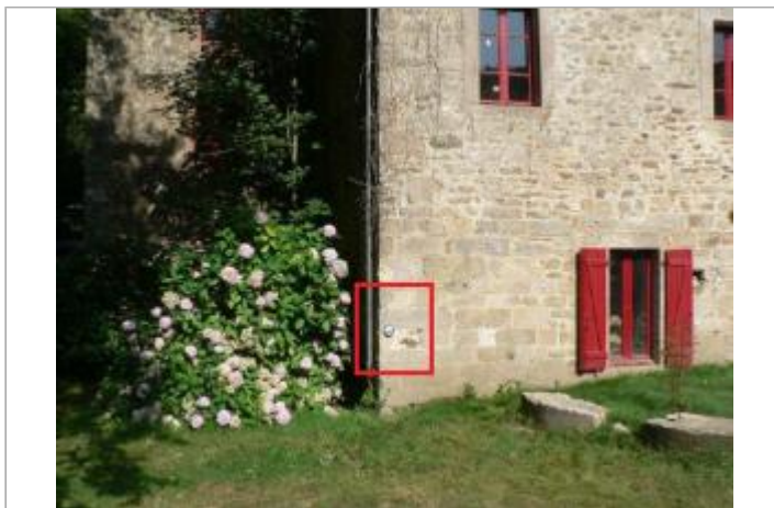
Mur du moulin en aval du barrage
