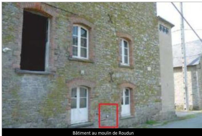
Bâtiment au moulin de Roudun
