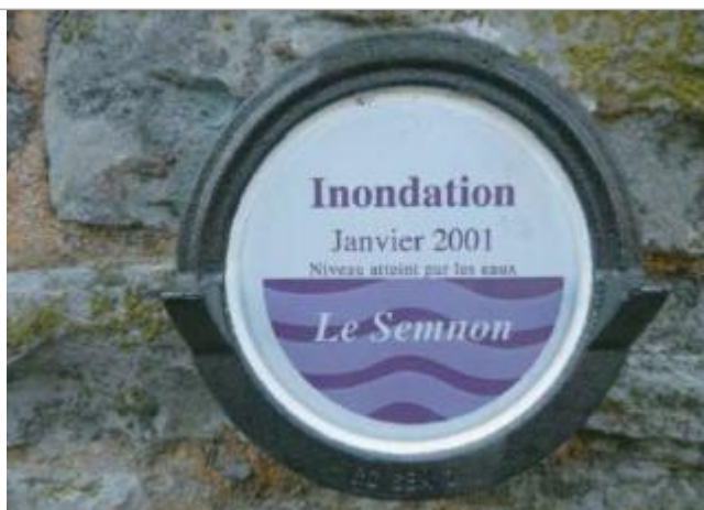
Repère normalisé sur le bâtiment du moulin
