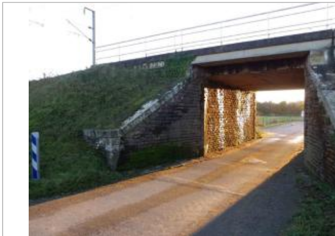
Sous le pont ferroviaire de la route longeant l'Oust
