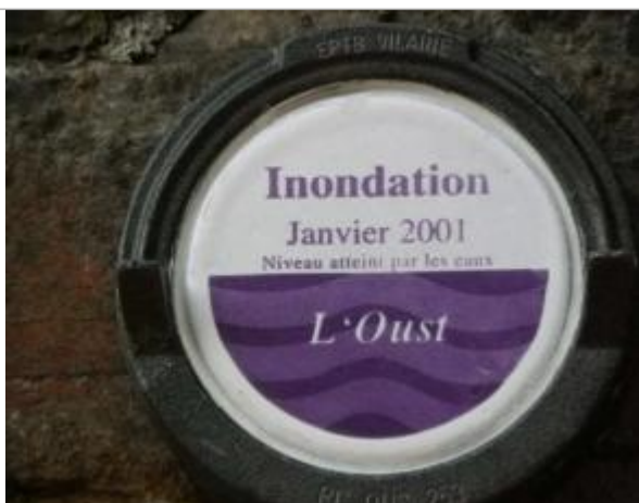
Repère normalisé sous le pont ferroviaire
