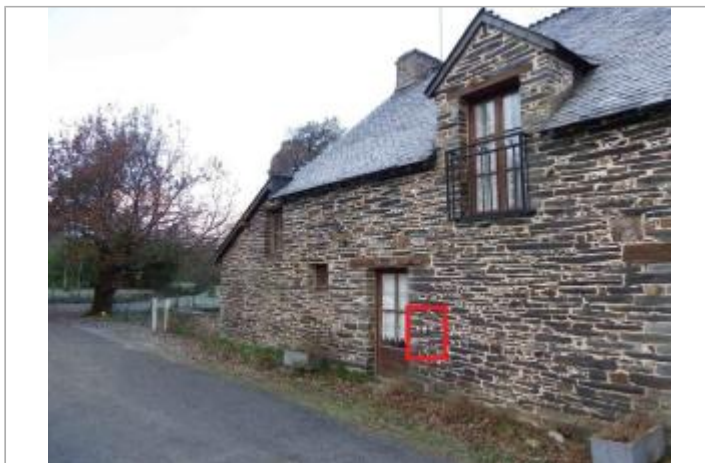
Bâtiment au moulin de la Née
