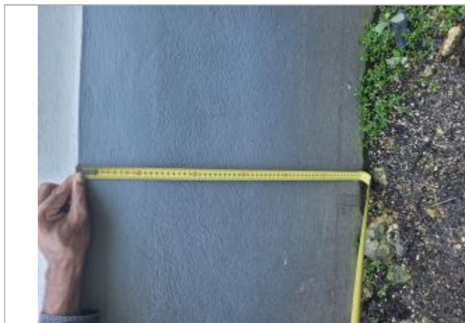
Dépôts de matières solides
