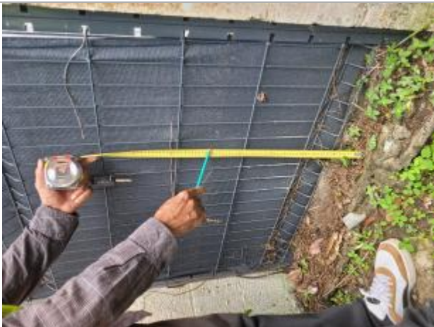
Dépôts de matières solides
