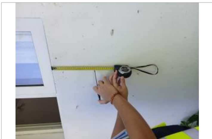
Témoignage d'une hauteur d'eau
