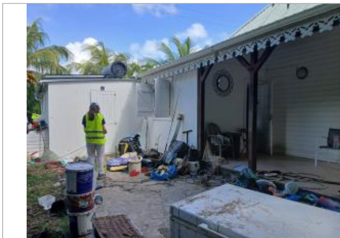
Façade extérieure maison individuelle
