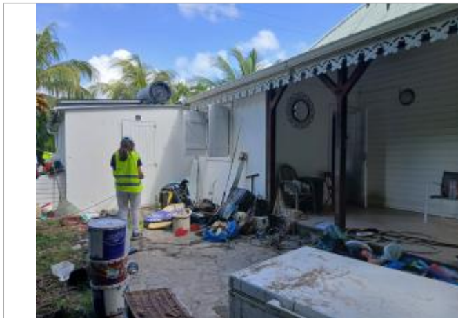
Façade extérieure maison individuelle
