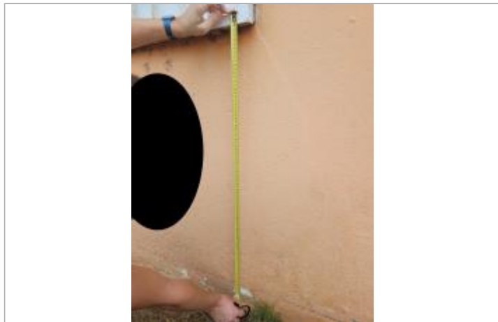
Dépôts de matières solides
