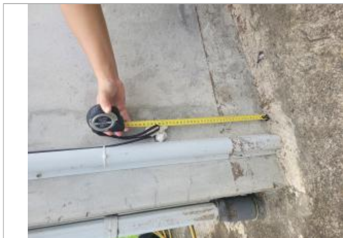
Dépôts de matières solides
