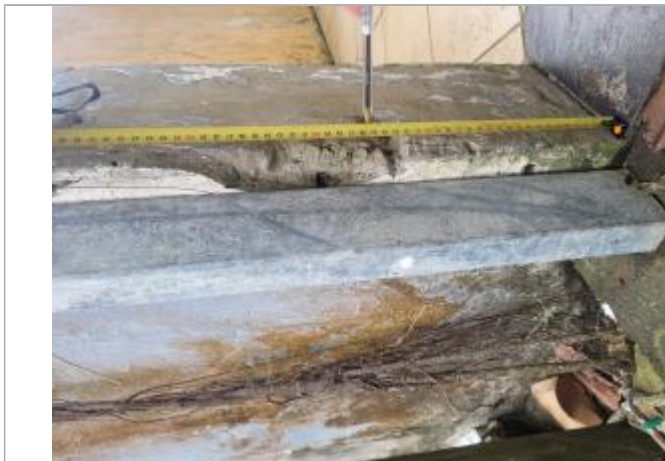
Témoignage d'une hauteur d'eau
