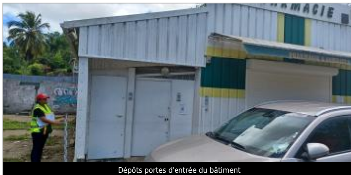
Dépôts portes d'entrée du bâtiment
